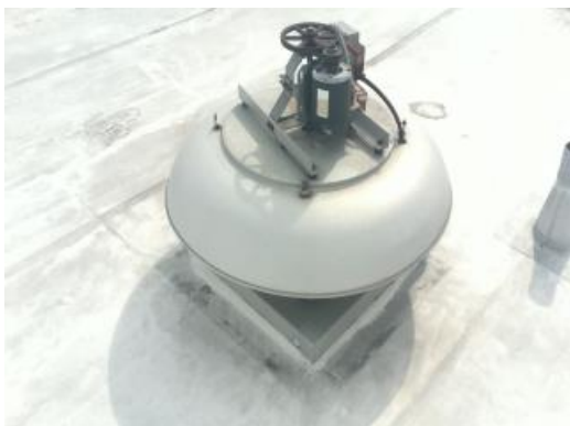
Exhaust Fan Missing Hood
