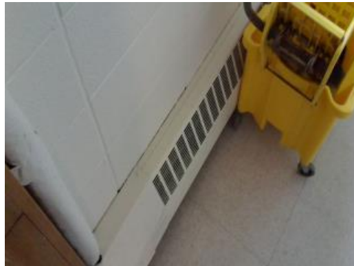
Radiant Fin Tube Heater
