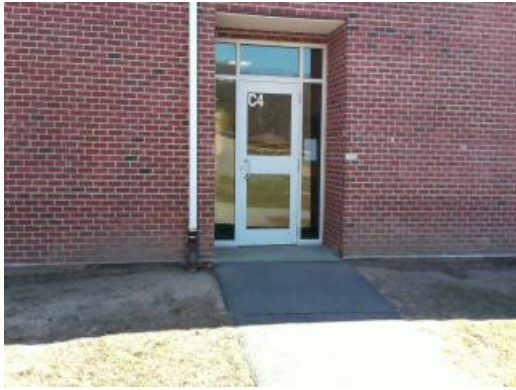
Exterior Storefront Door
