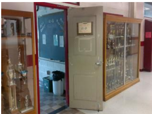
Original Wood Door
