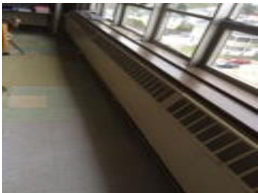
Fin Tube Radiant Heater
