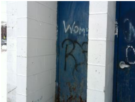
Replace Restroom Doors
